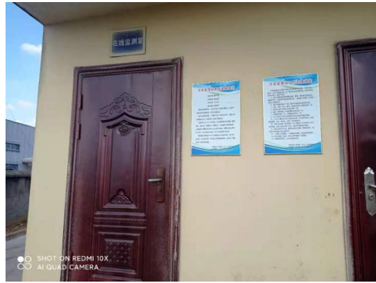
污水在线监测室
